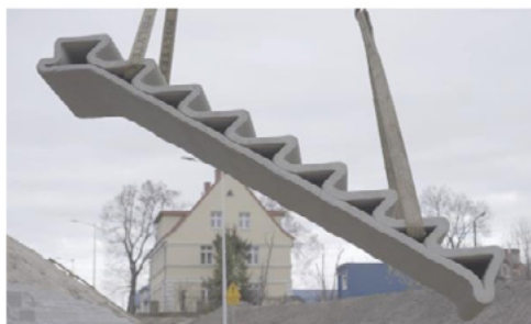
Rys. 20 Schody wykonane w technologii druku 3D,
