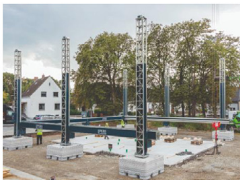
Rys. 18 Drukowany w 3D dom realizowany przez firmę PERI
